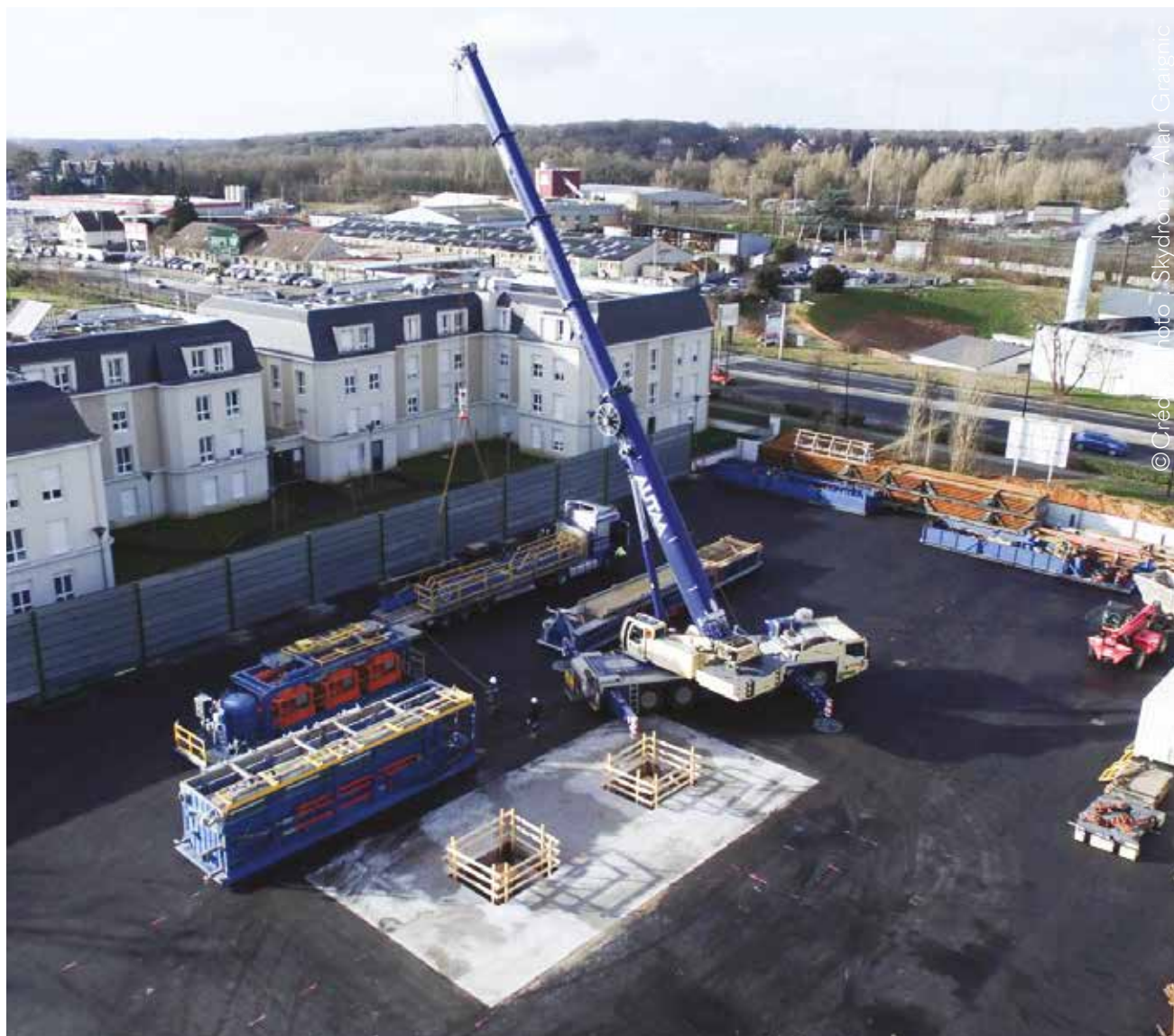
▲ Vue aérienne des deux puits de forage lors de la construction de la centrale Géothermique en 2017.
