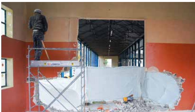
▲ Les murs de la rotonde, ainsi que les bancs, sont supprimés pour créer un large passage lumineux au sud de la halle.
